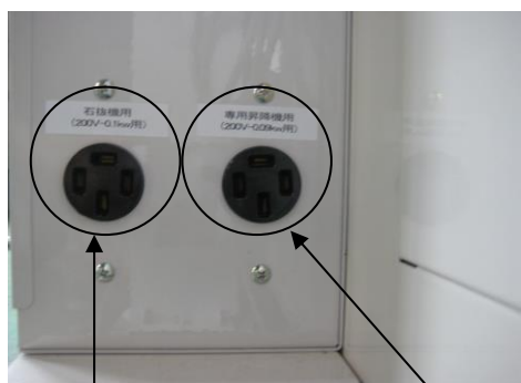
単独昇降機・石抜機コンセント (三相200v-0.1kw)
